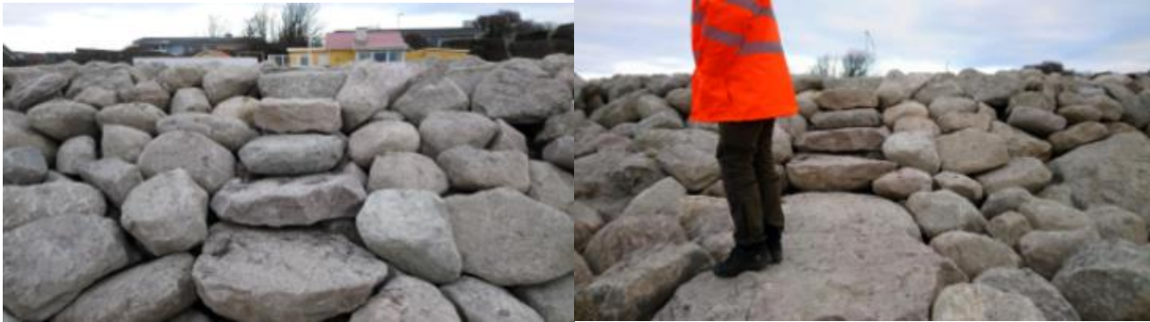
Figur 8.4 Eksempel på stentrappe i stensætning.
