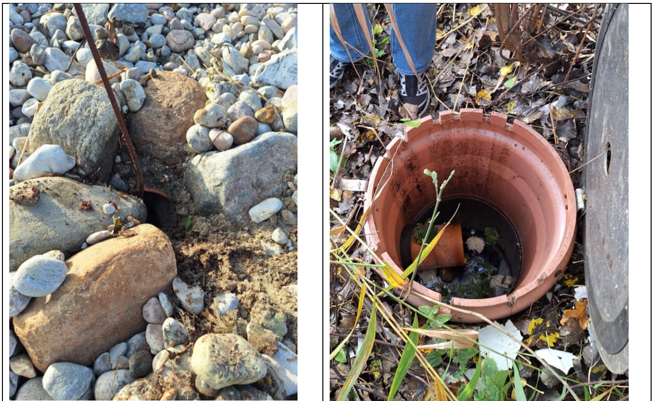
Figur 2: Udløbet på stranden (venstre) og brønden opstrøms fra udløbet (højre). Det orange rør i brønde vurderes at pege mod øst.
