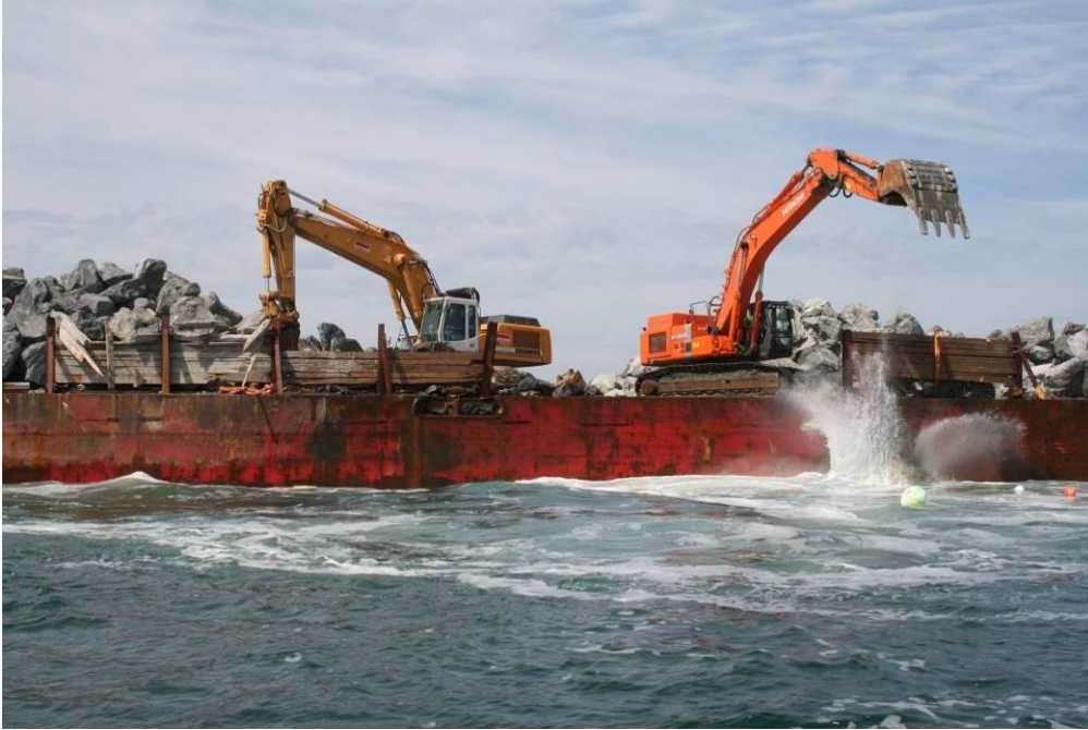
Figur 5.3: Gravemaskiner på flåden placerer sten til stenrev.
