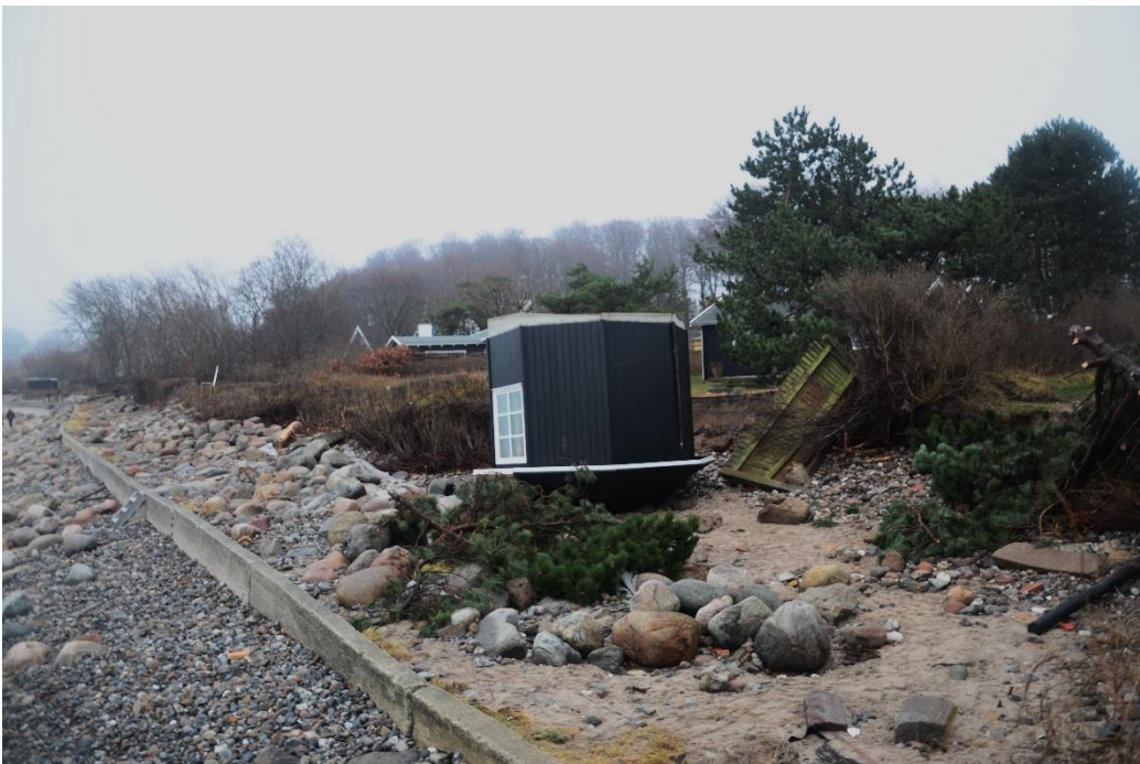
Figur 15: Erosion af skråningen i Gilleleje under og efter stormen Bodil den 6. december 2013. Foto: Christian Helledie
