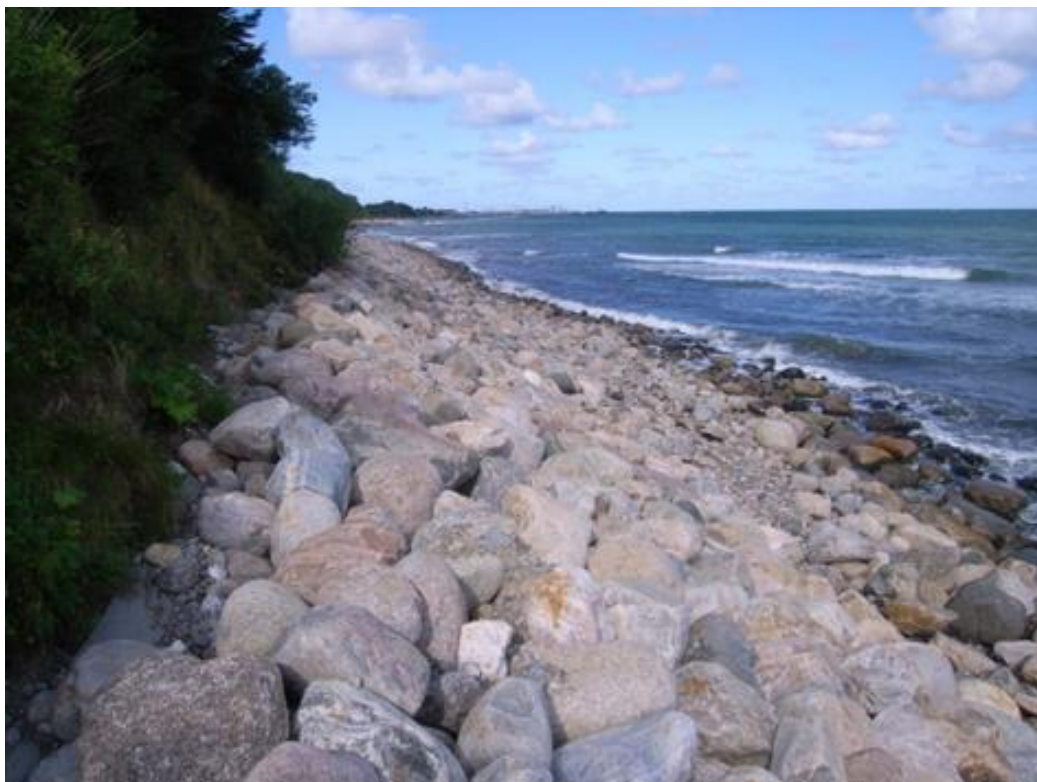
Figur 17: Stranden er forsvundet foran skråningsbeskyttelsen ved Nakkehoved. Foto: Christian Helledie
