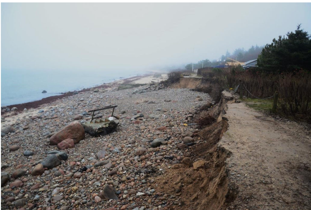
Figur 13: Erosion af skrånningen og skader på vejen ved Havstokken i Udsholt under og efter stormen Bodil den 6. december 2013. Foto: Christian Helledie
